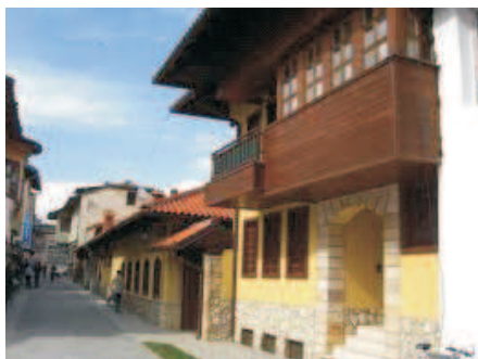
Rruga "Farkatarët" pas përfundimit të projektit, 2011 "Farkatarët" street after the completion of the project, 2011
