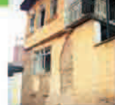
Mure masive (çerpiç) dhe ditare druri mbështjellur me ballë
