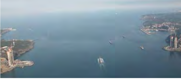
Şekil 6: 3. Köprü İnşaatı Garipçe-Poyrazköy görüntüleri, Şubat 2014 ( http://www.emlaktasondakika.com )
