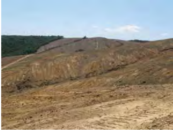
Şekil 4: 3. Köprü Bağlantı Yolları İnşaat Alanı, 2013
